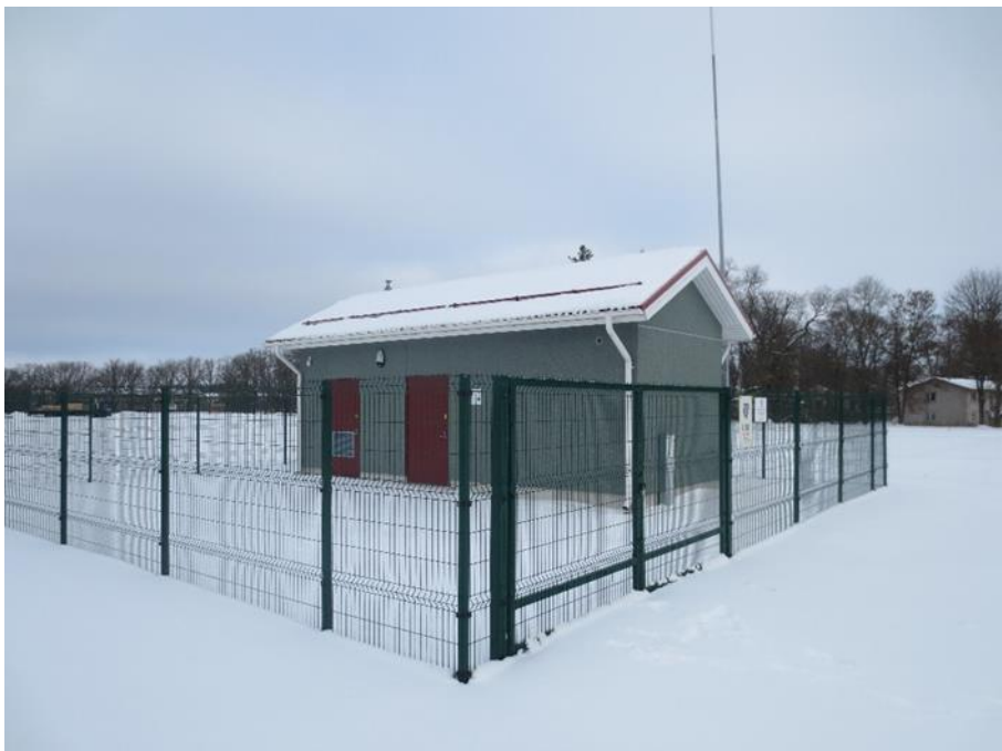
Joonis 4-5 Uhtna aleviku rekonstrueeritud asula puurkaevpumpila nr 3329 välisvaade (vasakpoolne uks avaneb generaatoriruumi)
