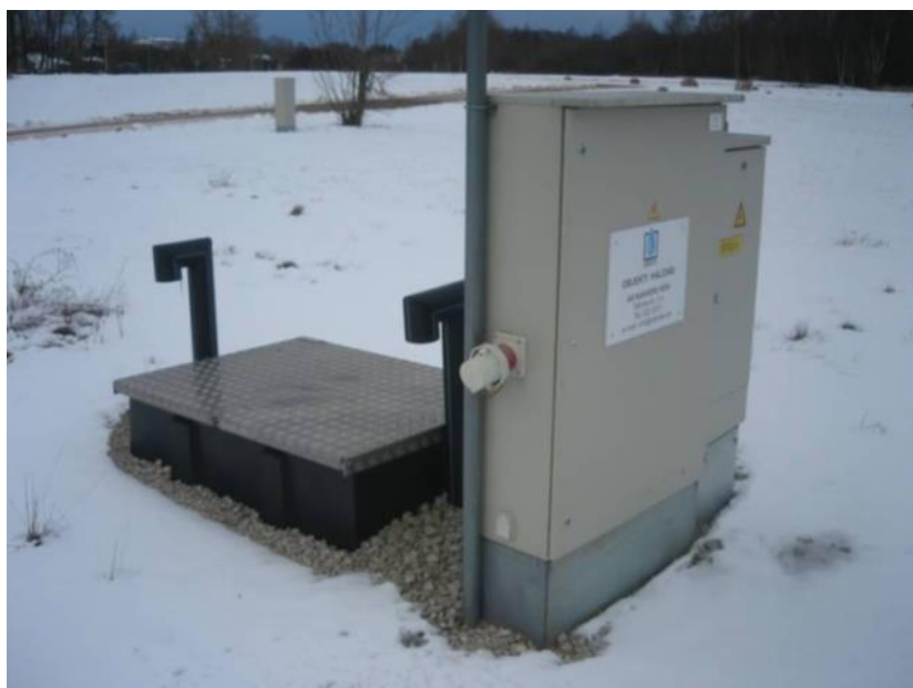
Joonis 5-1 Kompaktpumpla KPJ-1 kunagise Sõmeru reoveepuhasti territooriumil
