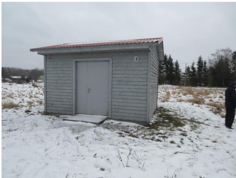
Joonis 4-12 Vaeküla Jaama puurkaevpumpla nr 25002 välisvaade
