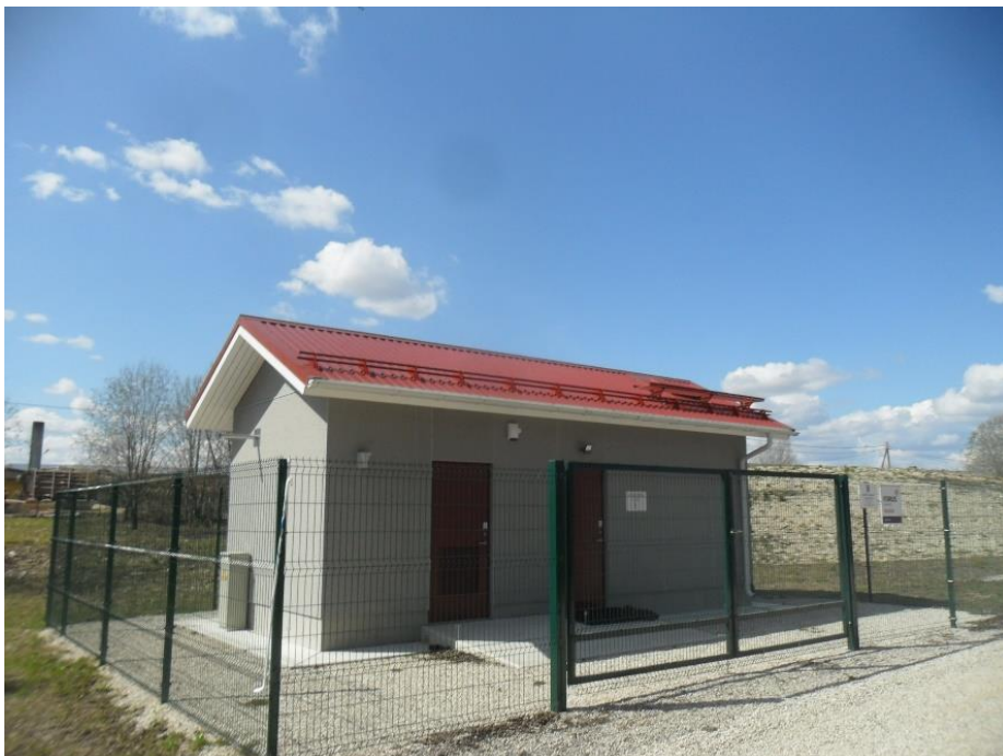
Joonis 4-18 Lasila puurkaevpumpla nr 62174 välisvaade (pumpla on klassikaline AS Rakvere Vesi viimase 10 aasta väikeste pumplahoonete projekt, vasak uks avaneb avariigeneraatoriruumi)
