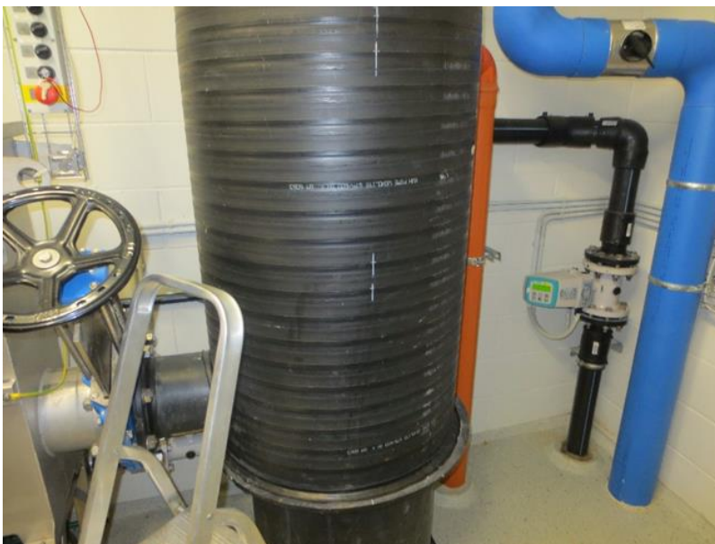
Joonis 5-10 Veltsi reoveepuhasti sisevaade. Vastuvõtumahuti
