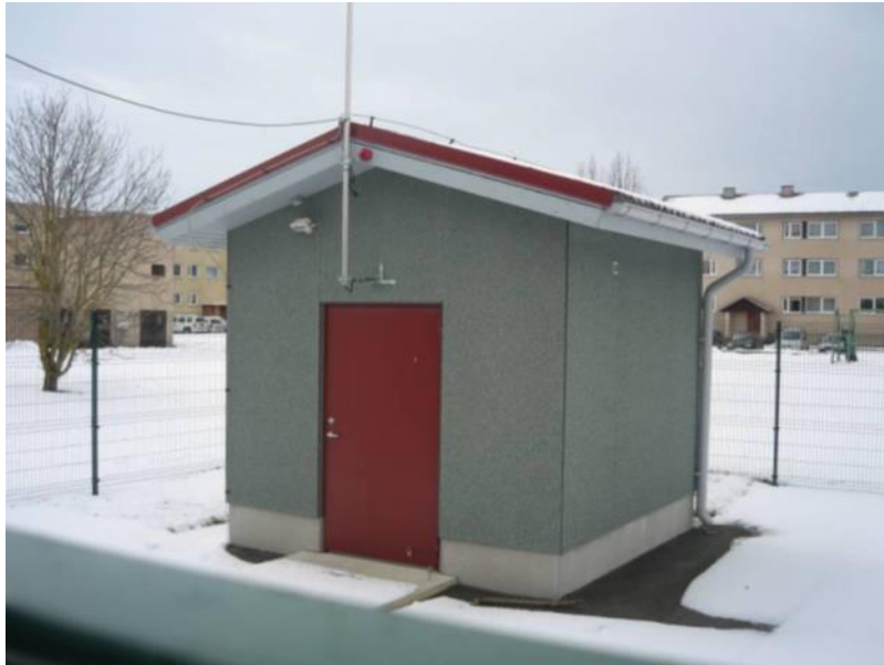
Foto 4-1 Sõmeru aleviku reservpuurkaev-pumpla nr 3110 (PK 1, mis on ühendatud puurkaevuga 2960, nr 2 ühtsesse süsteemi)
