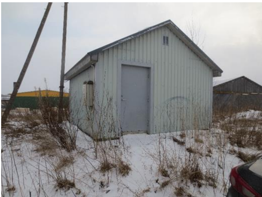
Joonis 4-19 Lasila puurkaevpumpla nr 2783 välisvaade (nagu pildilt näha, ei ole mõeldav puurkaevule tagada nõutavat sanitaarkaitseala)
