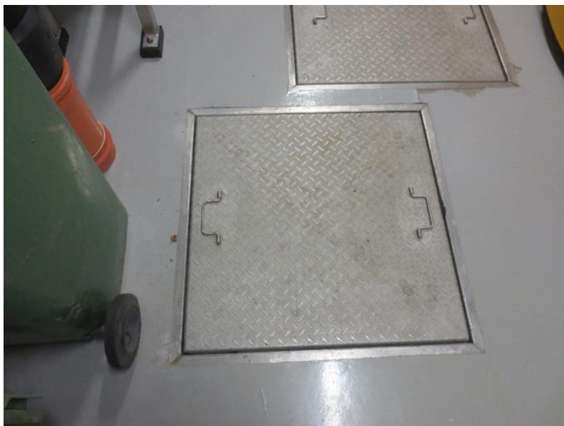
Joonis 5-5 Reoveepuhasti protsessimahutid (aerotank ja anaeroobne mahuti) asuvad puhasti hoone põranda all, antud luugid avavad aeratsioonikambri
