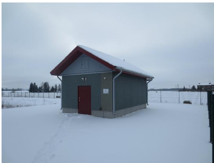
Joonis 5-12 Arkna reoveepuhasti välisvaade (vasakul on näha tühjendatud biotiiki)
