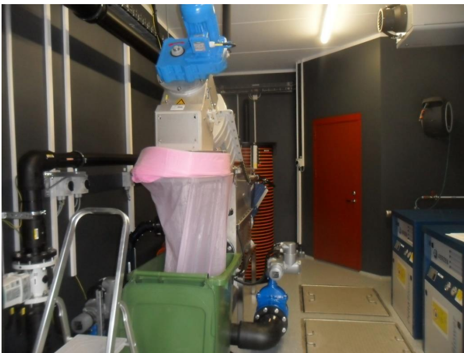
Joonis 5-16 Reoveepuhasti sisevaade, mehaaniline osa (automaatvõre) ning põranda all paiknevad protsessimahuti luugid
