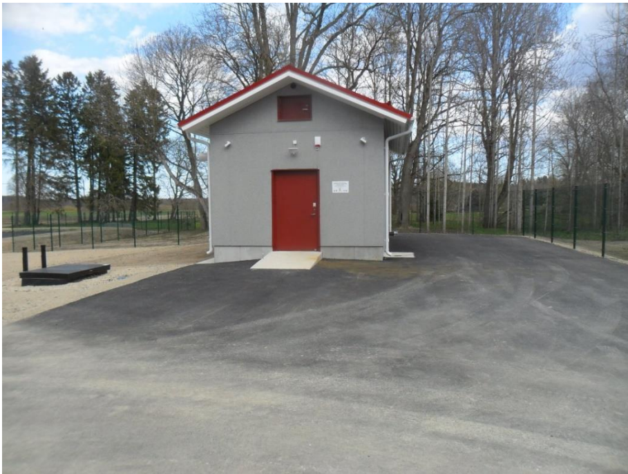
Joonis 5-15 Kohala reoveepuhasti välisvaade, tehnohoone ja reoveepumpla maapealne osa
