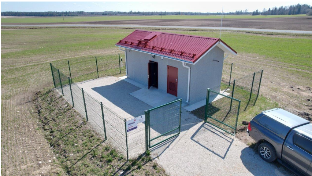
Joonis 4-20 Levala rekonstrueeritud puurkaevpumpla välisvaade (droonifoto, Janek Seidelberg, 05.05.2022)
