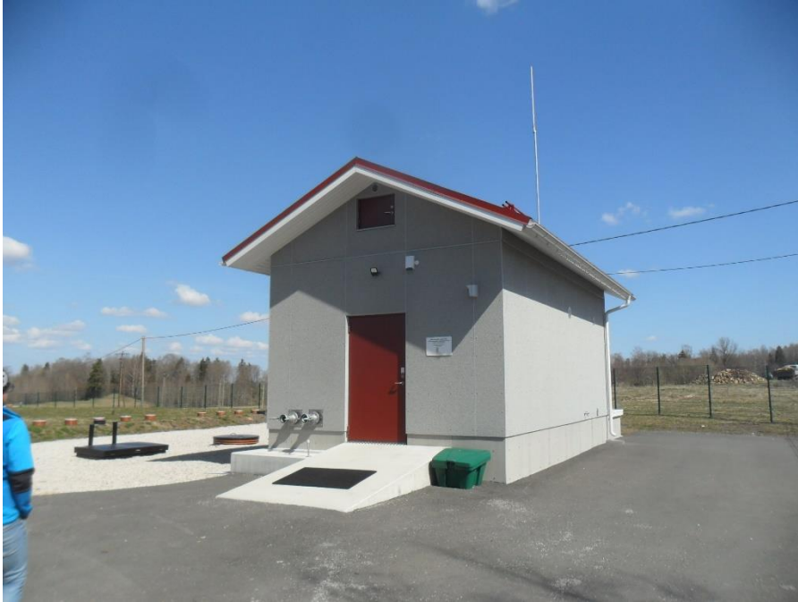
Joonis 5-17 Lasila uue reoveepuhasti välisilme
