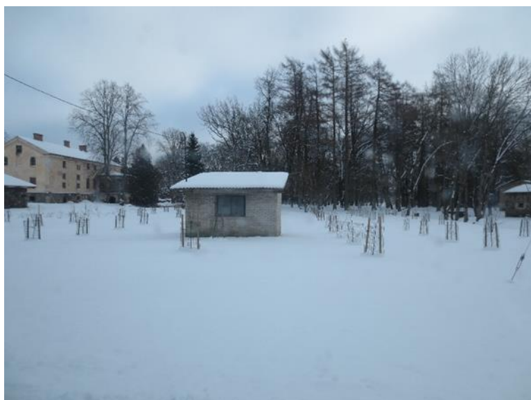
Joonis 4-15 Arkna kavandatava reserpuurkaevpumpla nr 3096 välisvaade
