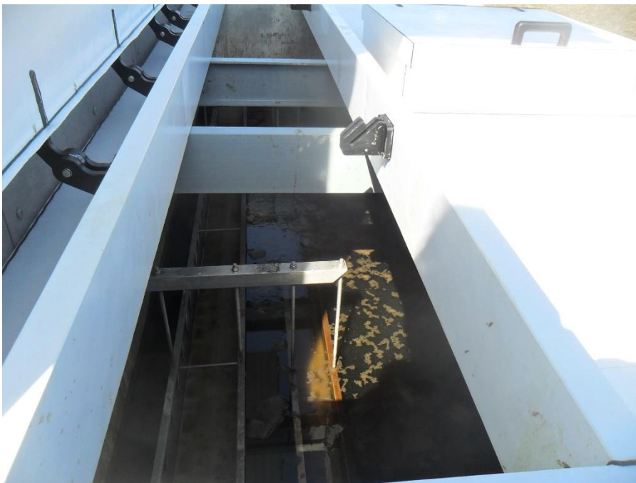
Joonis 5-18 Lasila RVP järelsetiti
