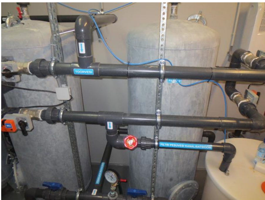
Joonis 4-4 Lepna puurkaevpumpla paarissurvefiltrid
