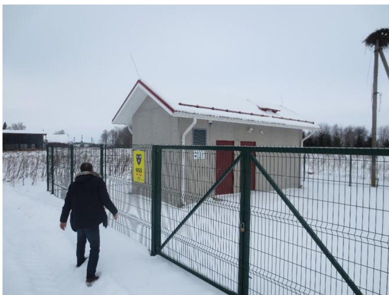
Joonis 4-10 Veltsi küla rekonstrueeritud puurkaevpumpla nr 3127 välisvaade (vasakpoolne uks avaneb generaatoriruumi)
