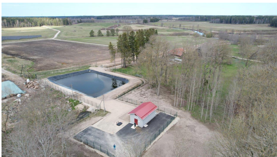
Joonis 5-14 Kohale reoveepuhasti välisvaade (droonifoto Rakvere Vallavalitsus, 05.05.2022)
