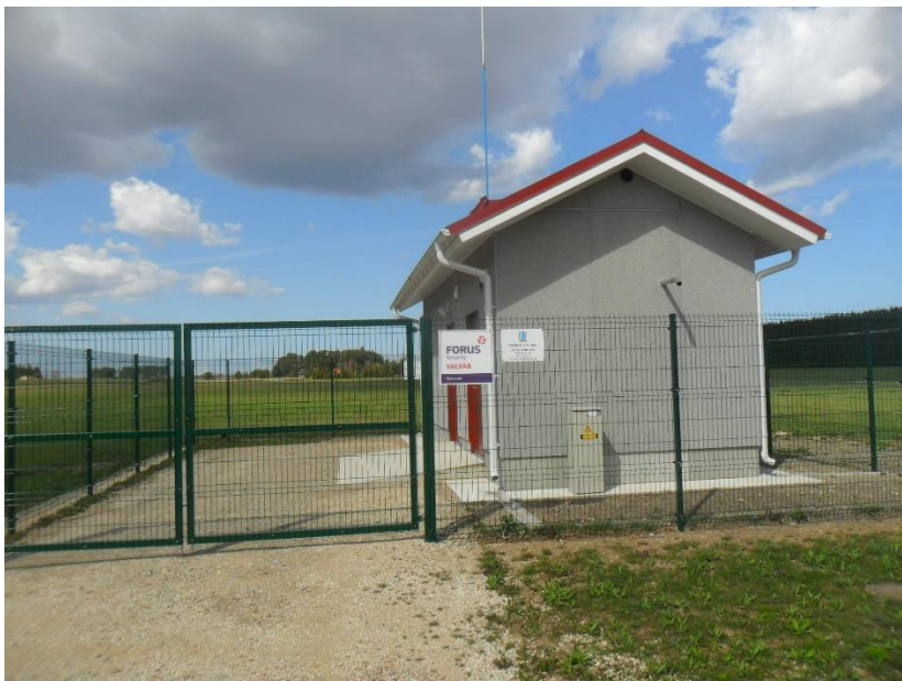
Joonis 4-16 Kohala uue puurkaevpumpla nr 63086 välisvaade
